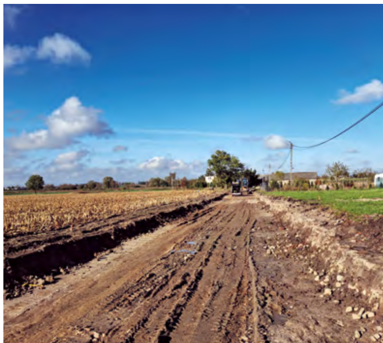
Przygotowanie koryta pod konstrukcję drogi w Gronówku. Fot. (LS)
