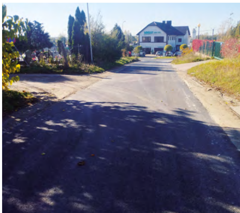
Ul. Kortowa w Lubiczu Dolnym już po remoncie. Fot. (MW)
